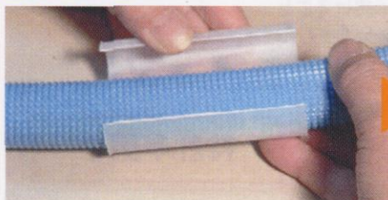
スリーブを保温材付きパイプにかはせて
